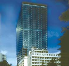
東京サンケイビル（東京都） 技術賞 建築設備部門
