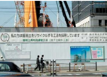
堺庁舎2期計画作業所（大阪府）のPR看板
