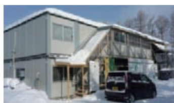
仮設事務所 外観
