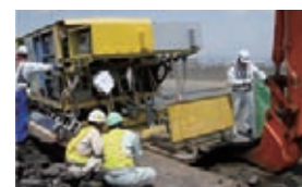
アスファルト舗装撤去の様子
