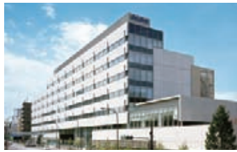
②第24回日経ニューオフィス推進賞 「アルプスビルディング」
