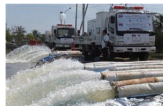
当社も参加した「国際緊急援助隊排水ポンプ車チーム」による排水活動の様子
