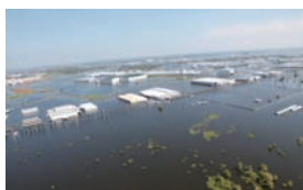
冠水した工業団地の一つ、ロジャナ工業団地
