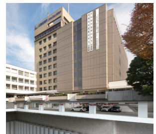
江東区役所本庁舎 工事完了イメージ図
