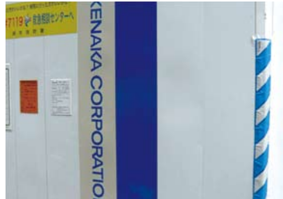
光触媒塗料を施した作業所仮囲いの適用例
