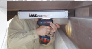
レジストグラフ木材劣化調査
