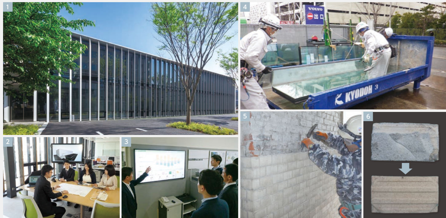
1.ZEB化した東関東支店外観 2.目的に応じてタイプを選べるコミュニケーションエリア 3.エネルギー収支のリアルタイム表示 4.ガラスの交換・分別搬出(東関東支店ZEB化工事) 5.タイルを再生して活かすための研(はつ)り取り作業(北業楼札幌本館作業所) 6.上:モルタル除去前のタイル 下:モルタル除去後のタイル 7.伐採木を活用したカフェ天井(女神の森セントラルガーデン) 8.女神の森セントラルガーデン外観 9.カフェ内観
