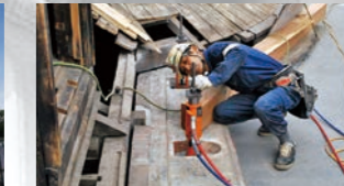
PC鋼棒によるプレストレス補強
