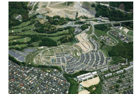
安威川土地区画整理事業 宅地造成工事
