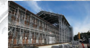
軽量鉄骨による素屋根のトラベリング工法
