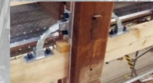
超塑性亜鉛アルミ合金制震ダンパー
