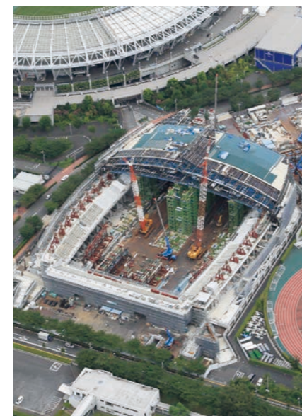
武蔵野の森アリーナ屋根工事の施工状況
