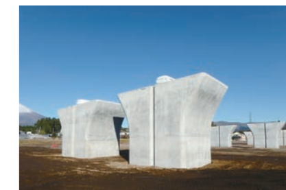
新東名ぐみ沢上高架橋
