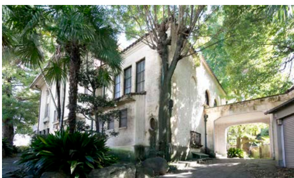
外観(改修工事前)
