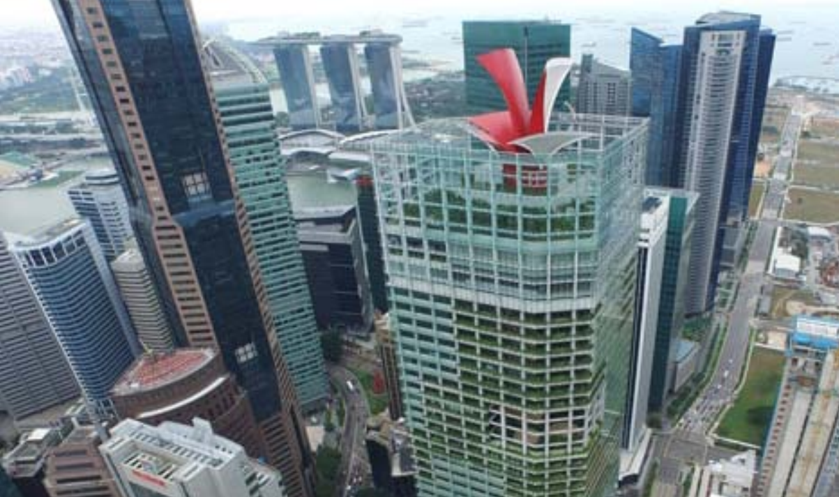
海拔200mの屋上庭園から自立する大型吸気口ファンネルは高さ45m、11階建てのビルに相当 (写真提供：Capita Land)
