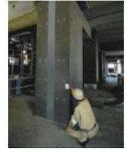
1階部分に設置された超高強度コンクリートの柱
