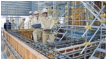
実際に組み立てられた鉄筋を図面と照合し、鉄筋径や本数、間隔、定着長さ、かぶり厚などの間違いや不具合を見極めるなどの実習を行う。
