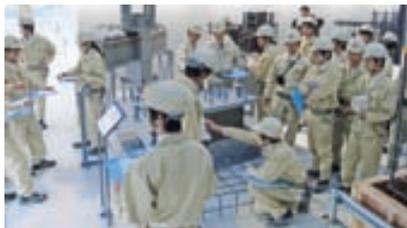
実物大の柱梁仕口、パイプシャフト模型を使い、実際に納まり具合を確認する。
