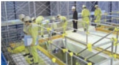
170の間違いを意図的に埋め込んだ鉄筋コンクリート造モックアップを使い、躯体の間違いや不具合を見極めるなどの実習を行う。
