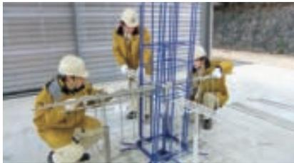
トライアルとして配筋工事などを実際に行い、材料・径の違い、配筋手順、結束具合の違いなどを知る。
