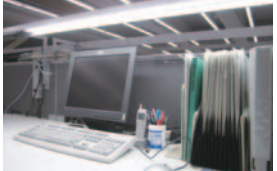
LED化したアンビエント照明(上)とタスク照明(下)
