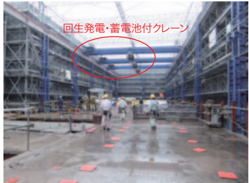
旧ホテルプラザ解体工事におけるハット内作業状況
