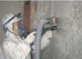
旧ホテルプラザ解体工事における吹付アスベスト剥離(試験施工)
