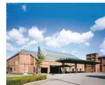
トヨタテクノミュージアム産業技術記念館 産業遺産であるレンガ造の工場の面影を残しつつ補強し、展示空間として再生しました。
