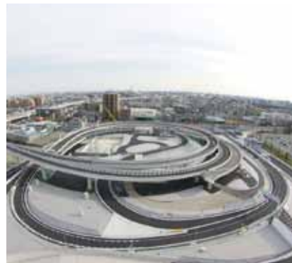
首都高速道路 川崎縦貫線 大師ジャンクション
