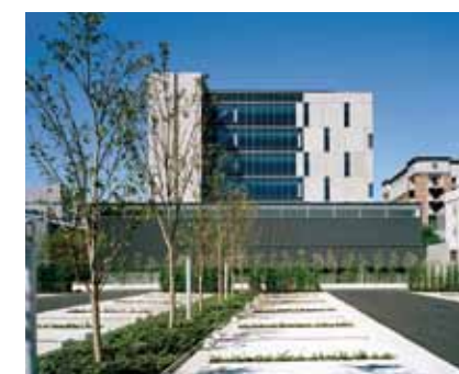
竹中工務店東京本店 自然光の取り込みや自然風を利用した空調、太陽光発電などにより自立したネット・ゼロエネルギービルを目指しています。
