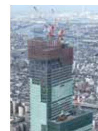
スライドカバー工法
