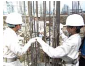
鉄筋の結束作業を体験
