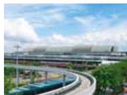
チャンギ国際空港第1ターミナル改修 (2011 シンガポール)
