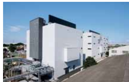
新A棟及び新B棟
