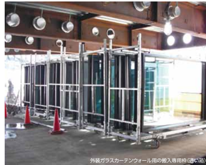
外装ガラスカーテンウォール用の搬入専用枠（通い箱）
