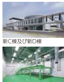
新C棟及び新D棟 新B棟 製造室内観
