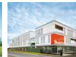
マキタベルギー新事務所・倉庫 (2012 ベルギー)
