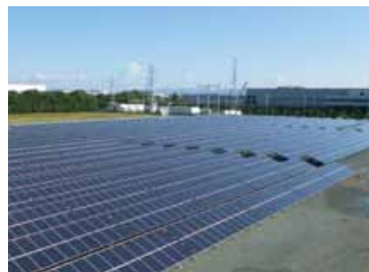
メガソーラー発電の施工例
