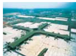
クアラルンプール国際空港 (1998 マレーシア)
