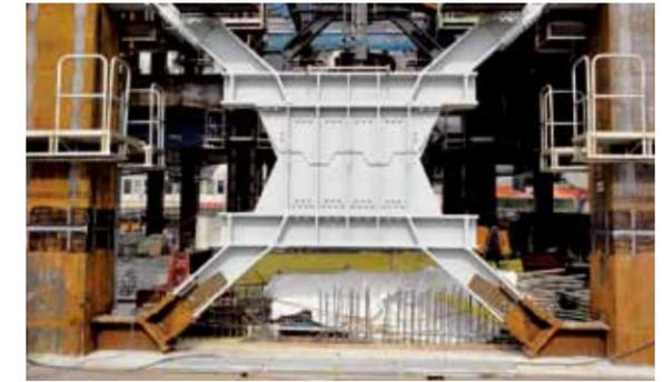
新合金を用いた制振ダンパー
