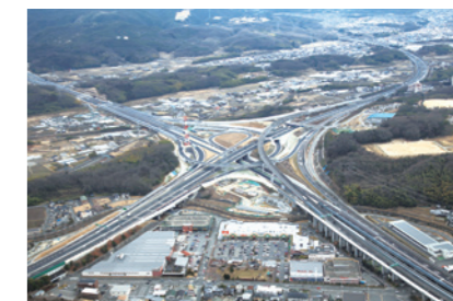
「新名神高速有野川西下部工」(提供:NEXCO西日本)
