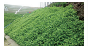
在来種を配合した法面吹付
