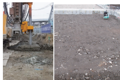
発生汚泥と敷地土壌の混練・再利用
