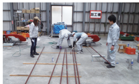
配管加工センターでのプレカット作業
