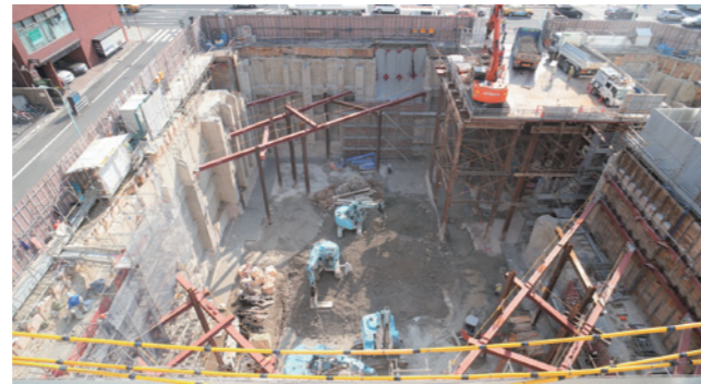
堅固な既存躯体を利用した地下工事
