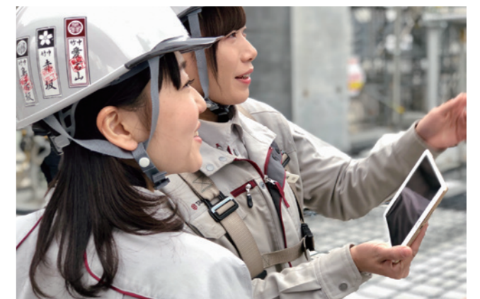
タブレット端末による現場管理
