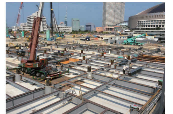
基礎+基礎梁の鉄骨化と作業床フラット化の状況
