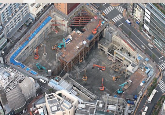
既存躯体を利用した地下工事全景
