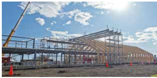
北海道産カラマツを使用した骨組み部
