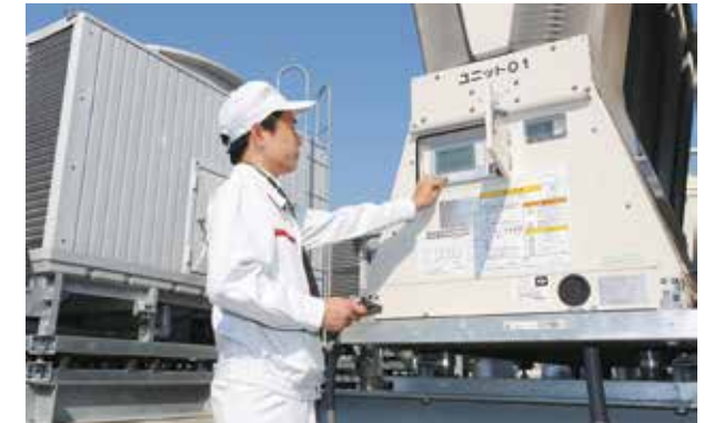
屋上設備点検
