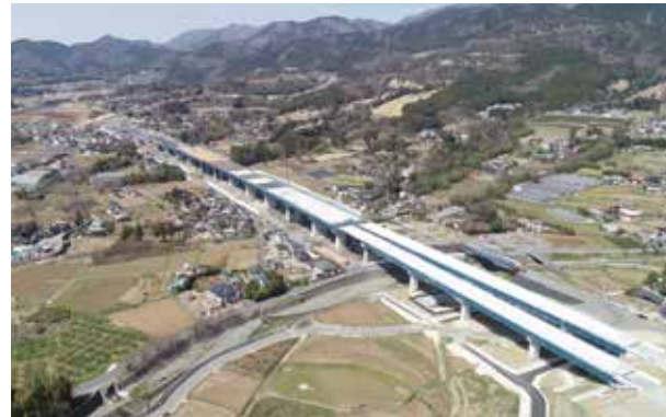
新東名高速 葛葉川橋
