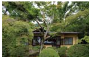
甍った竣工当時の本屋の外観
