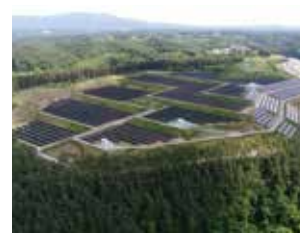
八戸市 是川太陽光工事
