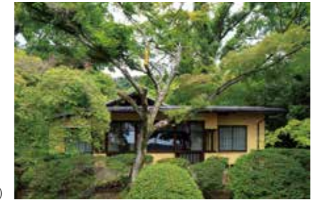
本屋の外観(1928年築)
