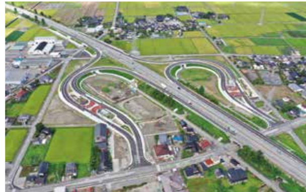
北陸自動車道 上市スマートインターチェンジ工事
