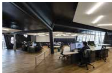
ワークスペースのインテリアには、柱・梁のみならず、スラブ(床)も鉄でつくられていることが現れます。
