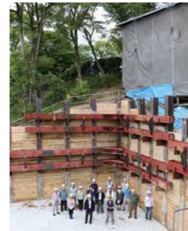
地下貯留水槽・ポンプ室 山留工事
