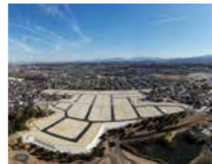
和泉はつが野三丁目開発工事
