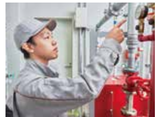
消火設備点検
