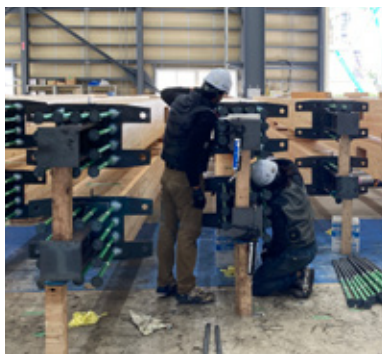
大阪・関西万博工事 場外ロジセンターでの事前組み立て
