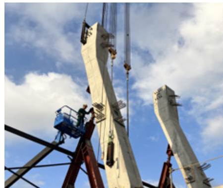
斜め柱のPC化により現地作業を大幅に削減
