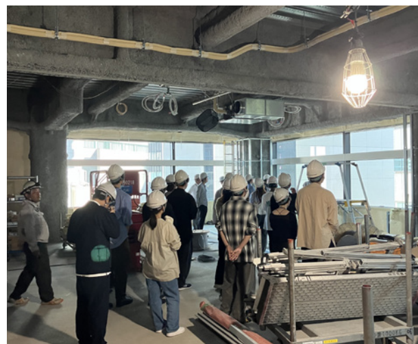
構造演習講座の一環としての、大学生による作業所見学
