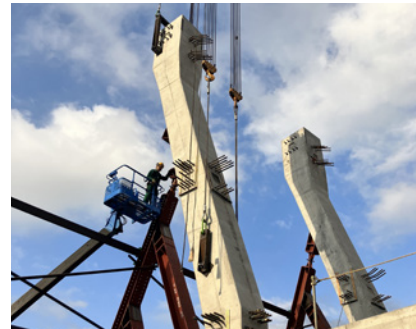
斜め柱のPC化により現地作業を大幅に削減
