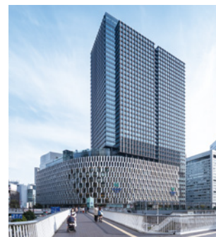
2022 大阪梅田ツインタワーズ・サウス
