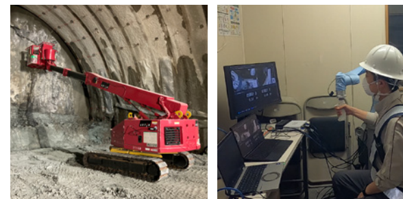
トンネル切羽の岩判定を遠隔から行う実証実験の様子
