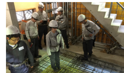
設備技術：鉄筋の設備納まり演習
