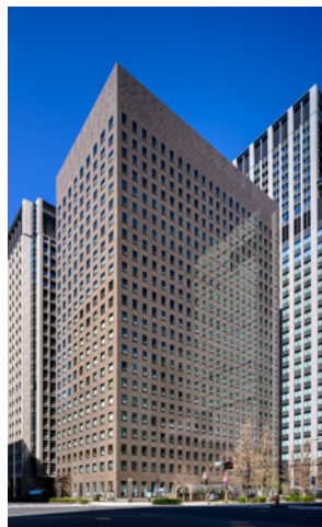
大手センタービル
