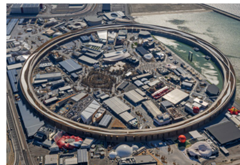
2025 大阪・関西万博 大屋根リング(西工区)
