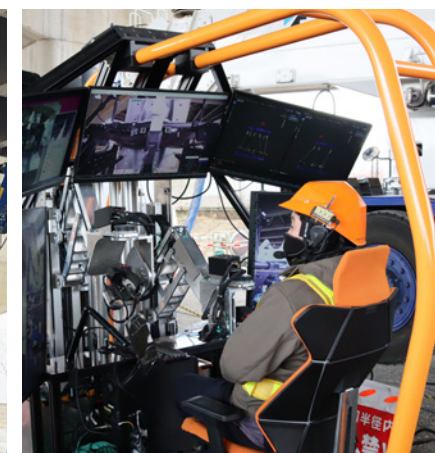
取り付け作業は遠隔操作機からモニターを見ながら、繊細で敏感な操作が可能
