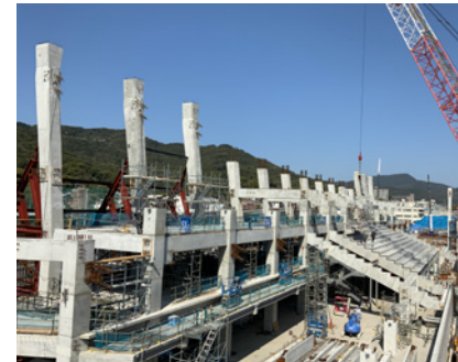
多数の柱を含む躯体工事を短期間で施工
