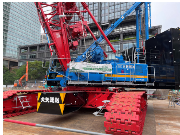
リニューアブルディーゼル燃料対応の建設機械稼働状況
