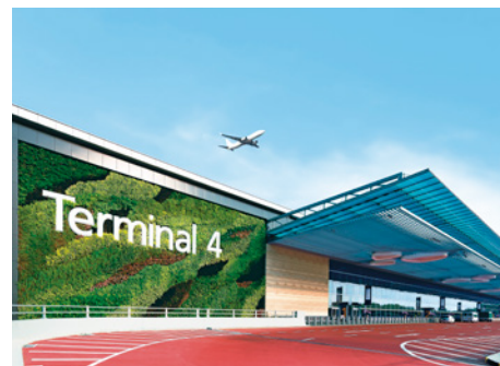
2017 チャンギ空港 第4ターミナルビル
