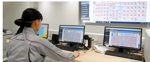
管理センターからのリモート監視・制御
