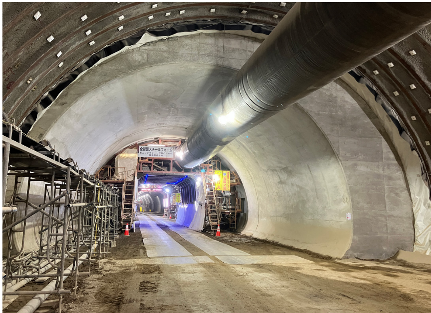
トンネル切羽の岩判定を遠隔から行う実証実験の様子
