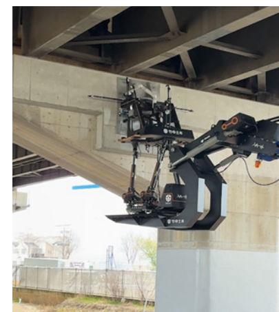
橋梁の桁下に重量物を取り付け、ボルトを仮締結する(イメージ)
