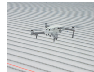
ドローンによる検査状況
