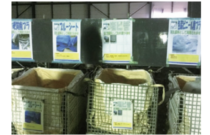
分別項目を協議し、細分化したBOXを設置
