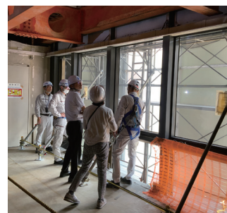
既存建物でアルミサッシの解体手順を 検討している様子
