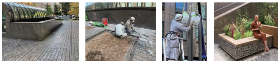
独特の風合いのある外構床 外構床石活かし取り状況 外灯取り外し状況 解体ガラを使用した花壇
