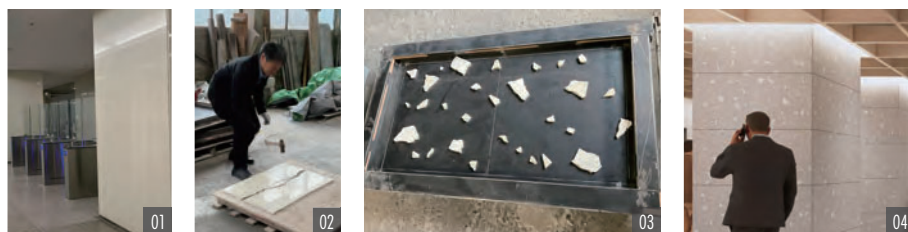
01 既存エントランス壁石 ⇒ 02 壁石の石割加工 ⇒ 03 割石をテラゾー打ち込み枠へ設置 ⇒ 04 テラゾーの白い斑点模様 アップサイクルの流れ
