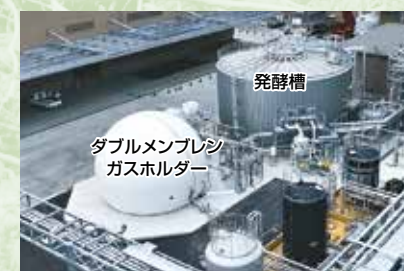
原料投入（設計） 50t/日 生産排水流入量（設計） 750m 3 /日
