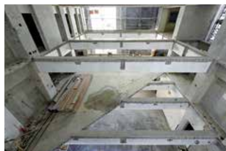
改修工事の様子。使用しないエリアの床を撤去。
