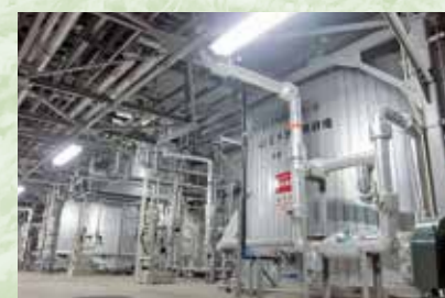
生ごみ投入量（設計） 3t/日 厨房排水流入量（設計） 700m 3 /日
