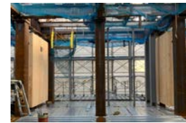
設置されたCLT
