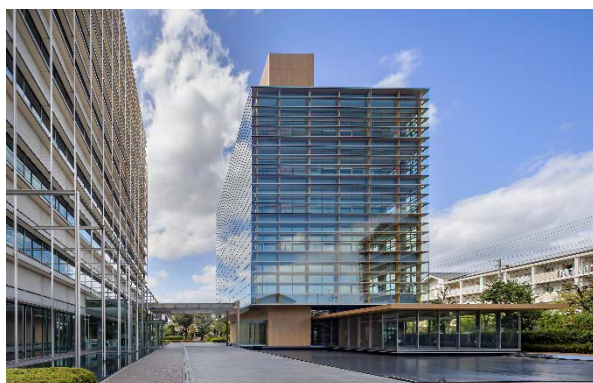
池に浮かぶタクマビル新館
