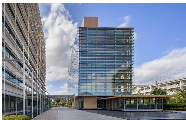
池に浮かぶタクマビル新館
