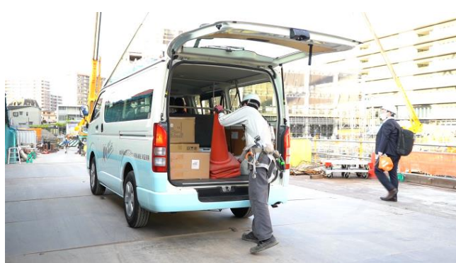
移動中に、建設現場に届いた資材を降ろす
