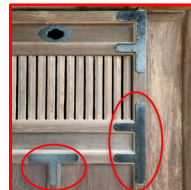
太宰府天満宮末社志賀社本殿に適用された REI-和-TETSU でつくられた金具の製作・取付状況
