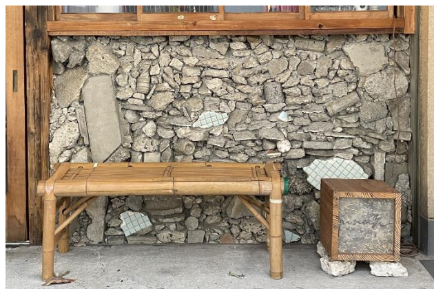
コンクリートガラでつくった石垣(参考)
