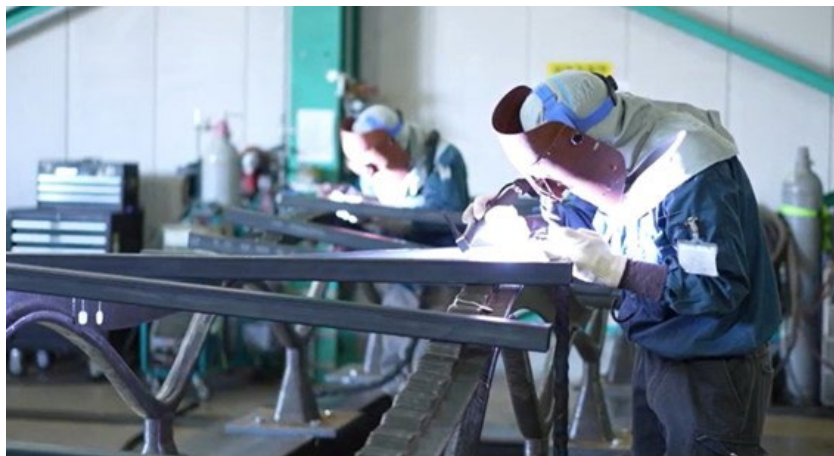
組み立て溶接の状況
