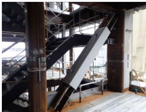
開発ダンパーの取付状況
