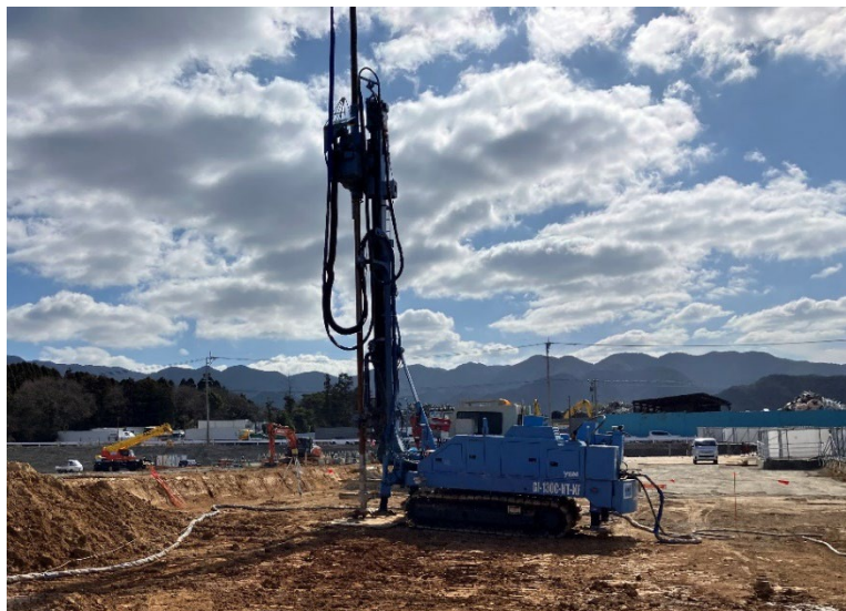
CUCO-CO 2 固定地盤改良の施工状況
