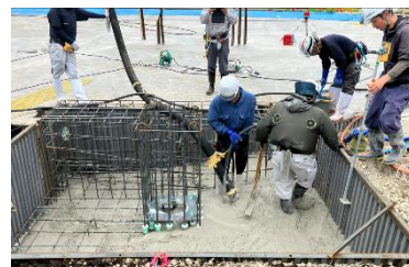
サーキュラーコンクリートの打設状況
