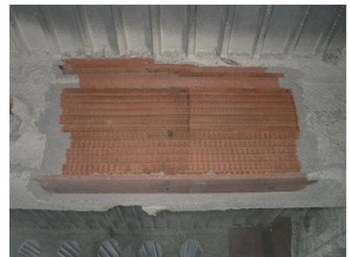
Photo 11 剥離後の鉄骨状況
