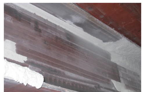
Photo 8 剥離後の鉄骨状況
