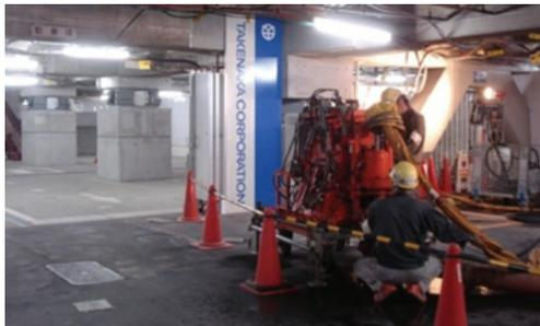
Photo 2 小型掘削機による施工状況
