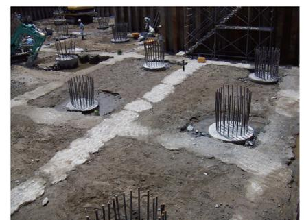
Photo 2 TOFT工法の施工例
