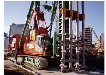
Photo 1 4軸施工機械
