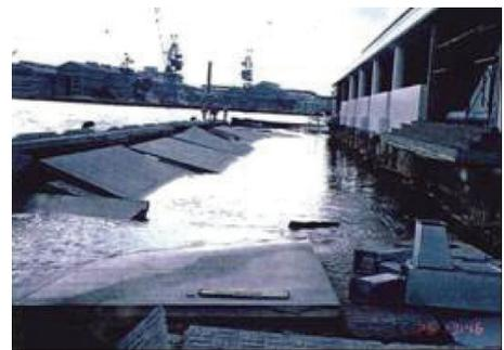
Photo 4 埠頭南側岸壁の被害
