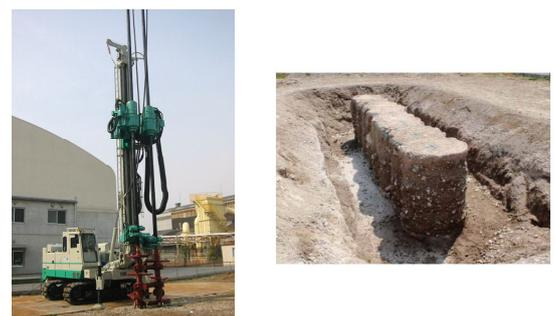
Fig. 8 新開発の2軸機と試験施工による改良体
