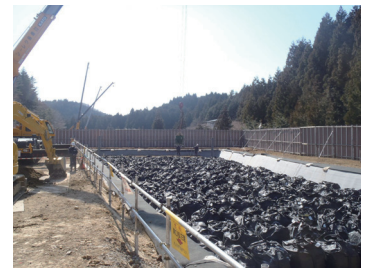
Photo 2 大型土のう格納状況 Containment of sandbag
