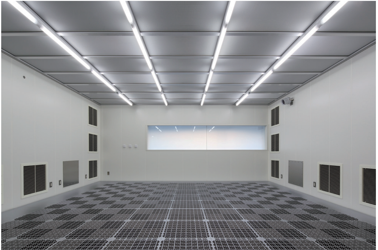
Photo 2 1F 可視化クリーンルーム 1F cleanroom for visualization of air flow
