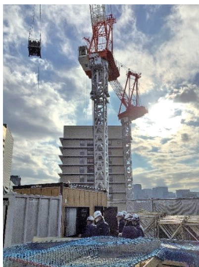
Photo. 13 クレーン稼働の様子 Crane in operation
