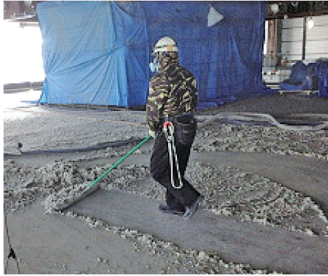
Photo 9 耐火被覆工事における清掃作業 Cleaning work in fireproof coating work
