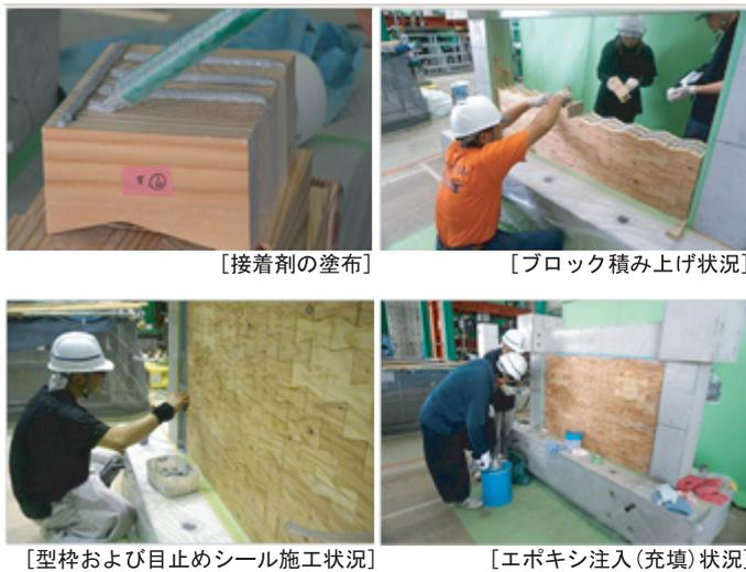
Fig. 12 施工状況 (縮小試験体)
