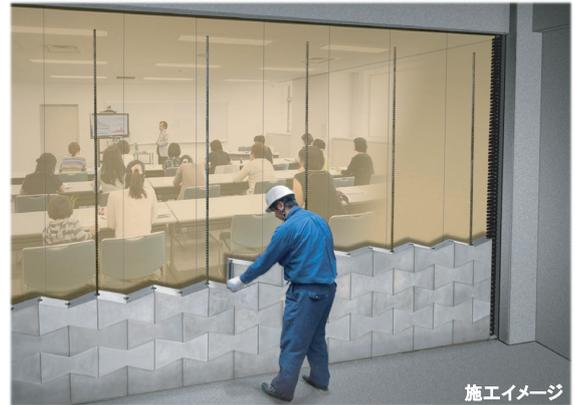
Fig. 1 既往工法（蝶形コンクリートブロック壁補強）<sup>1)</sup>
