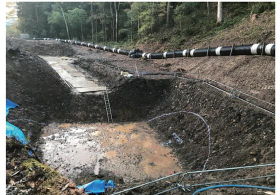
(a) 河川切り回し・保護盛土掘削完了
