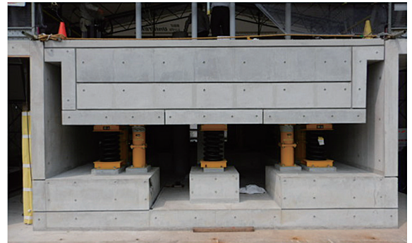
Photo 3 防振床のモックアップ Mockup of anti-vibration floor
