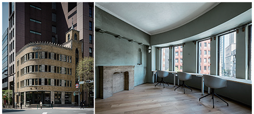
Fig. 4 既存オフィスビルの歴史を活かしたリノベーション事例 (堀ビル) A case of renovation of an office building featuring its history (Hori Building)
