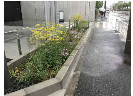
Photo 6.1 レインスケープの施工事例 Example of Rainscape installation
