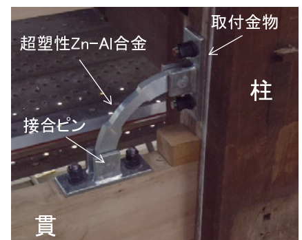
Photo 2 伝統木造建築用超塑性Zn-Al合金制振ダンパーの取付状況 Superplastic Zn-Al alloy seismic damper
