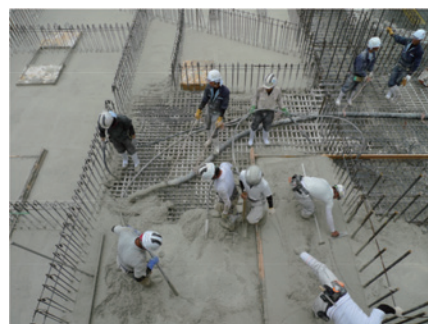
Photo 3 ECMコンクリートの打込み状況 Casting of ECM concrete
