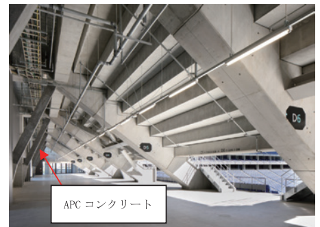
Photo 2 吹田市立スタジアム（ F_c200N/mm^2 APCコンクリートを用いたスリム柱の適用例） Application of APC concrete to RC slim pillar
