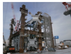
Photo 3 ダンパー設置状況 Installation of FMS alloy damper
