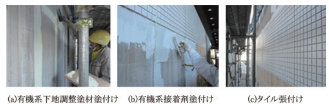
Photo 1 本工法の施工手順 Work procedure
