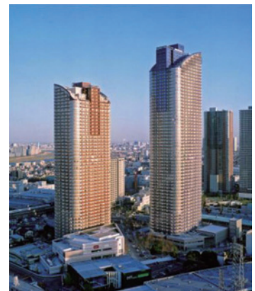
Photo 1 パークシティ武蔵小杉（ F_c150N/mm^2 APCコンクリートの適用例） Application of APC concrete to RC high rise building
