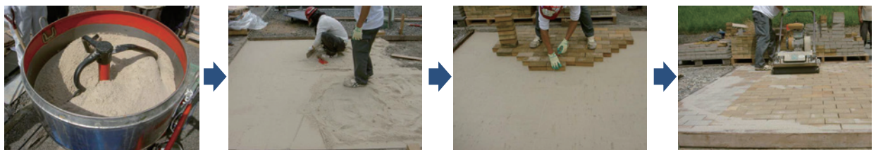
Photo 1 ブロック舗装の作製手順
