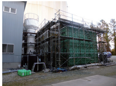
Photo 1 馬鈴薯澱粉工場におけるコンパクトメタン発酵システム外観 Compact methane fermentation system in potato starch plant
