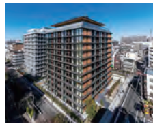
地上 12 階建の共同住宅
